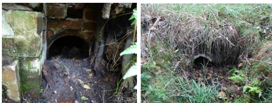
FOT. 8 OBIEKT NR 732.1.20 – ISTNIEJĄCY PRZEPUST W LEŚNICTWIE OLSZA, ODDZIAŁ 33J; A) WLOT PRZEPUSTU, B) WYLOT PRZEPUSTU
