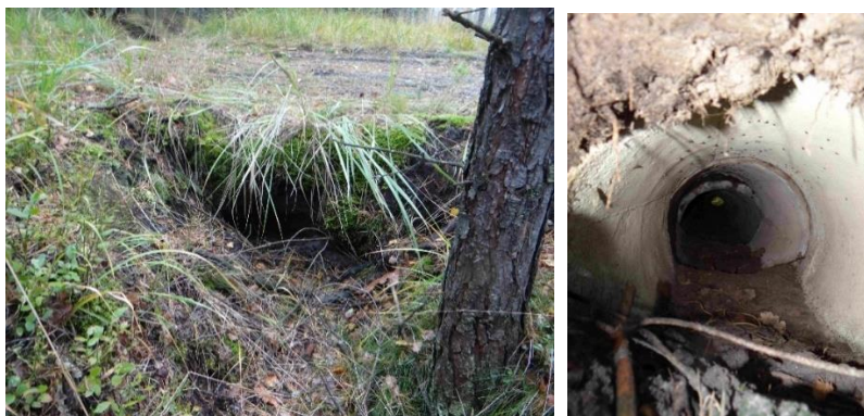
FOT. 9 OBIEKT NR 732.4.10 – ISTNIEJĄCY PRZEPUST W LEŚNICTWIE GRUSZECZKA, ODDZIAŁ 200A; A) WLOT PRZEPUSTU, B) ŚWIATŁO PRZEPUSTU
