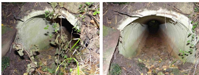
FOT. 10 OBIEKT NR 732.4.14 – ISTNIEJĄCY PRZEPUST W LEŚNICTWIE GRUSZECZKA, ODDZIAŁ 199H; A) WLOT PRZEPUSTU, B) WYLOT PRZEPUSTU
