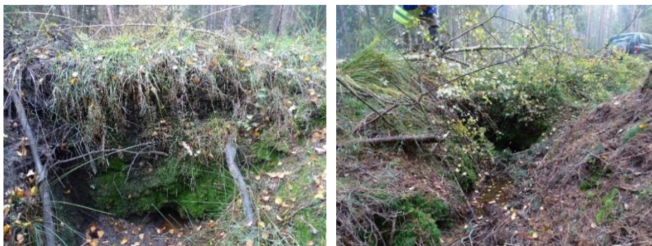
FOT. 4 OBIEKT NR 732.1.13 – ISTNIEJĄCY PRZEPUST W LEŚNICTWIE OLSZA, ODDZIAŁ 29D; A) WLOT PRZEPUSTU, B) WYLOT PRZEPUSTU
