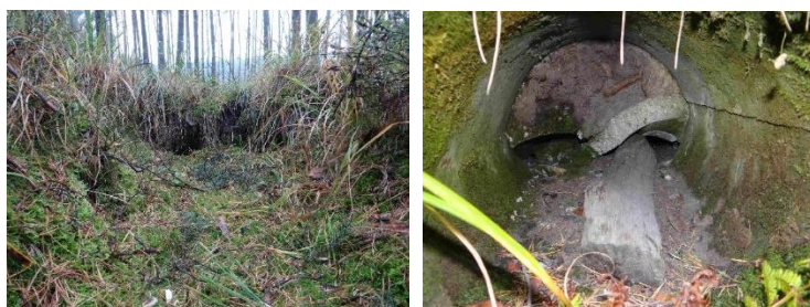
FOT. 5 OBIEKT NR 732.4.16 – ISTNIEJĄCY PRZEPUST W LEŚNICTWIE GRUSZECZKA, ODDZIAŁ 195A; A) WLOT PRZEPUSTU, B) ŚWIATŁO PRZEPUSTU
