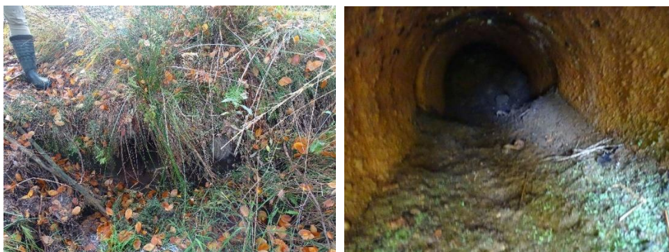
FOT. 2 OBIEKT NR 732.1.9 – ISTNIEJĄCY PRZEPUST W LEŚNICTWIE OLSZA, ODDZIAŁ 17H; A) WLOT PRZEPUSTU, B) WIDOK WNĘTRZA PRZEPUSTU
